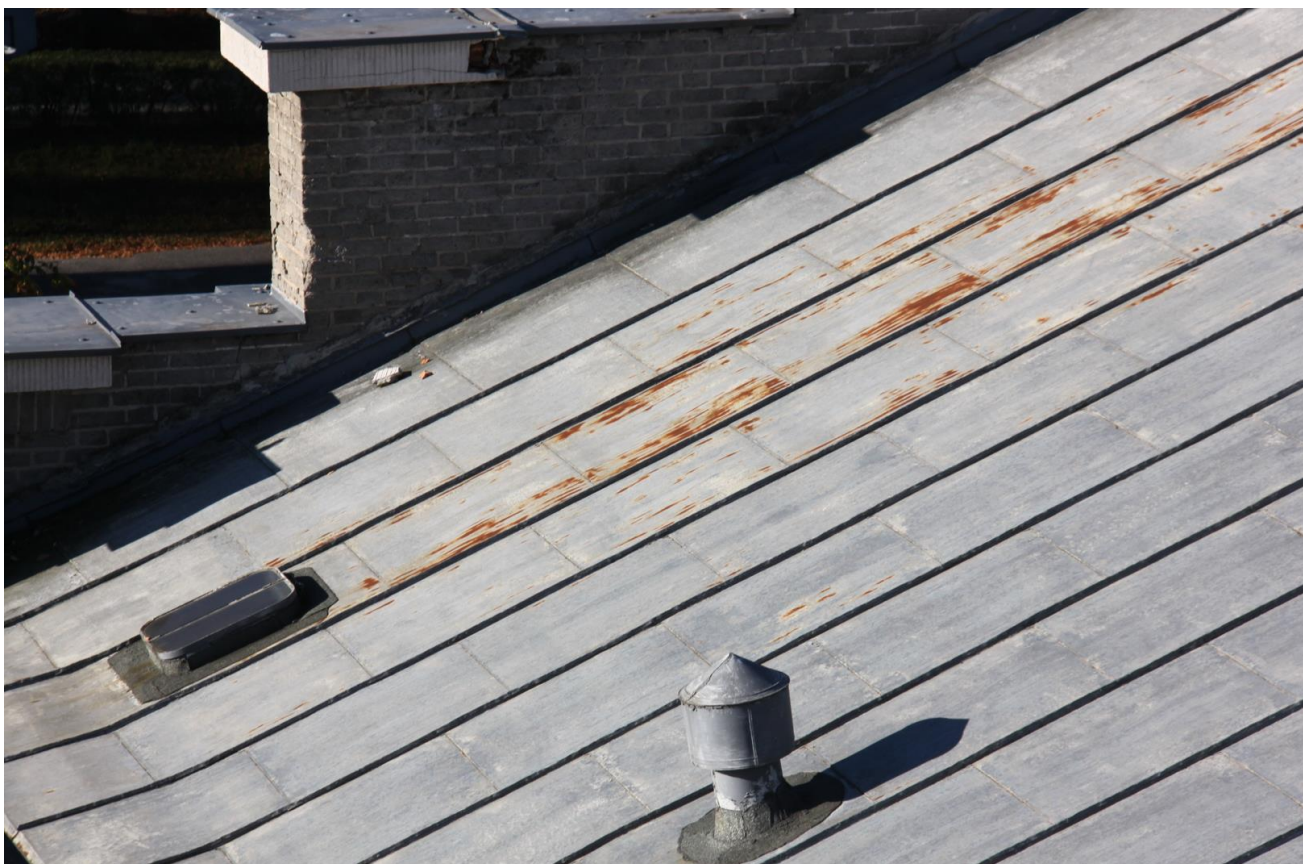
Fot. 13. Stan zachowania połaci dachowej. Arkusze blachy ocynkowanej z widoczną miejscową korozją.
