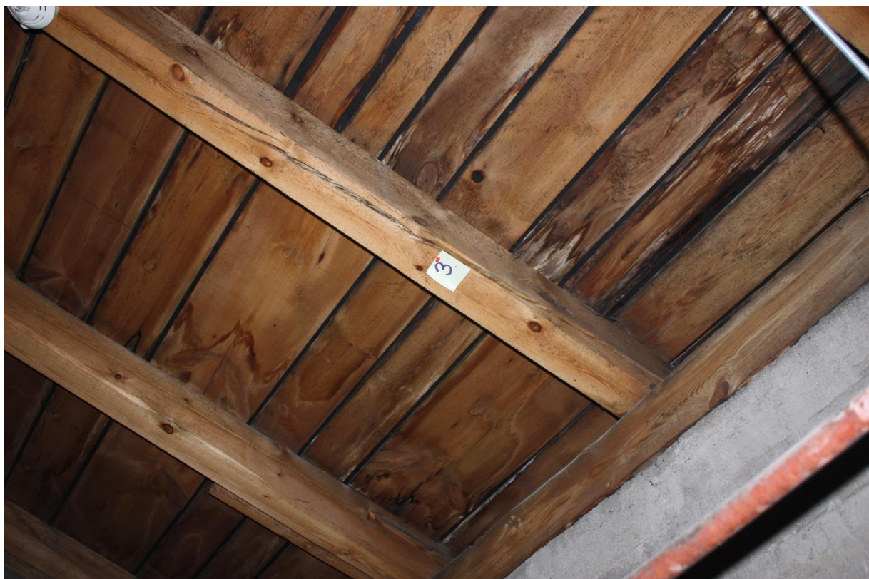
Fot. 3. Pęknięcie powierzchniowe i boczne.
