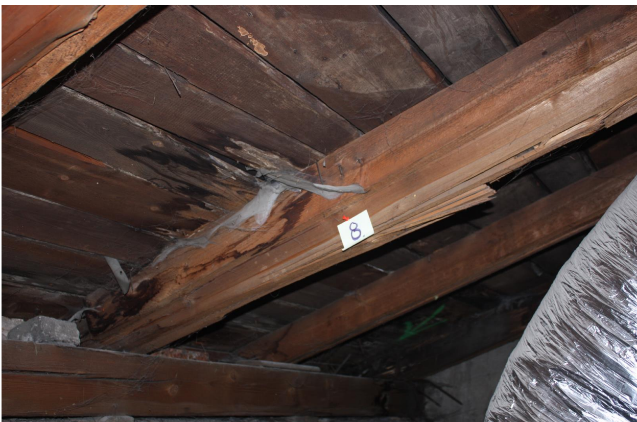
Fot. 8. Krokiew uszkodzona, spękana, wzmacniana deskami
