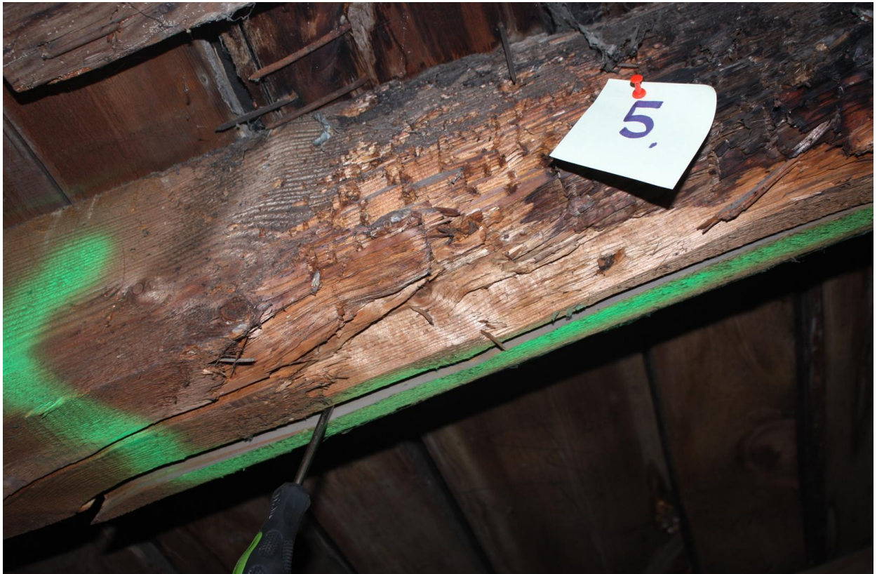
Fot. 5. Pęknięcie powierzchniowe i czołowe (rozwarstwienie) z ubytkami
