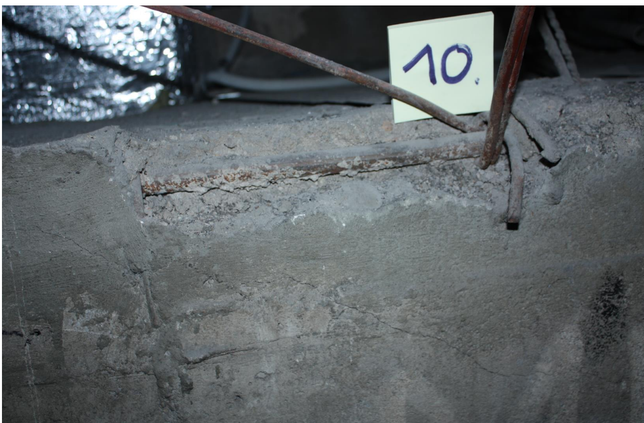
Fot. 10. Zniszczona otulina pręta zbrojeniowego
