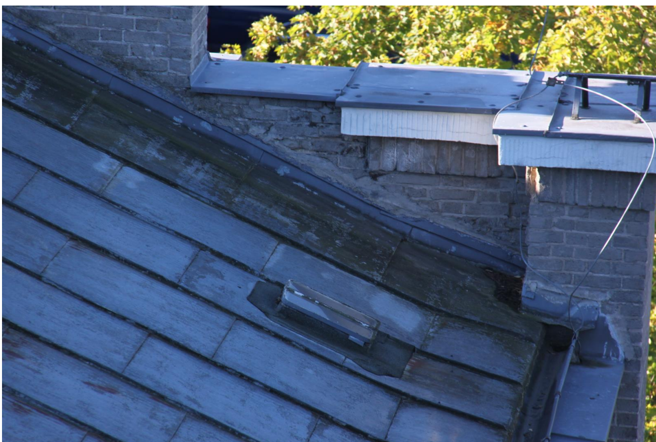
Fot. 12. Stan zachowania pokrycia dachowego. Naroże z nieprawidłowo wykonanym przeciwspadkiem –miejsce występowania uszkodzenia nr 4 więźby dachowej (brak kozubka).
