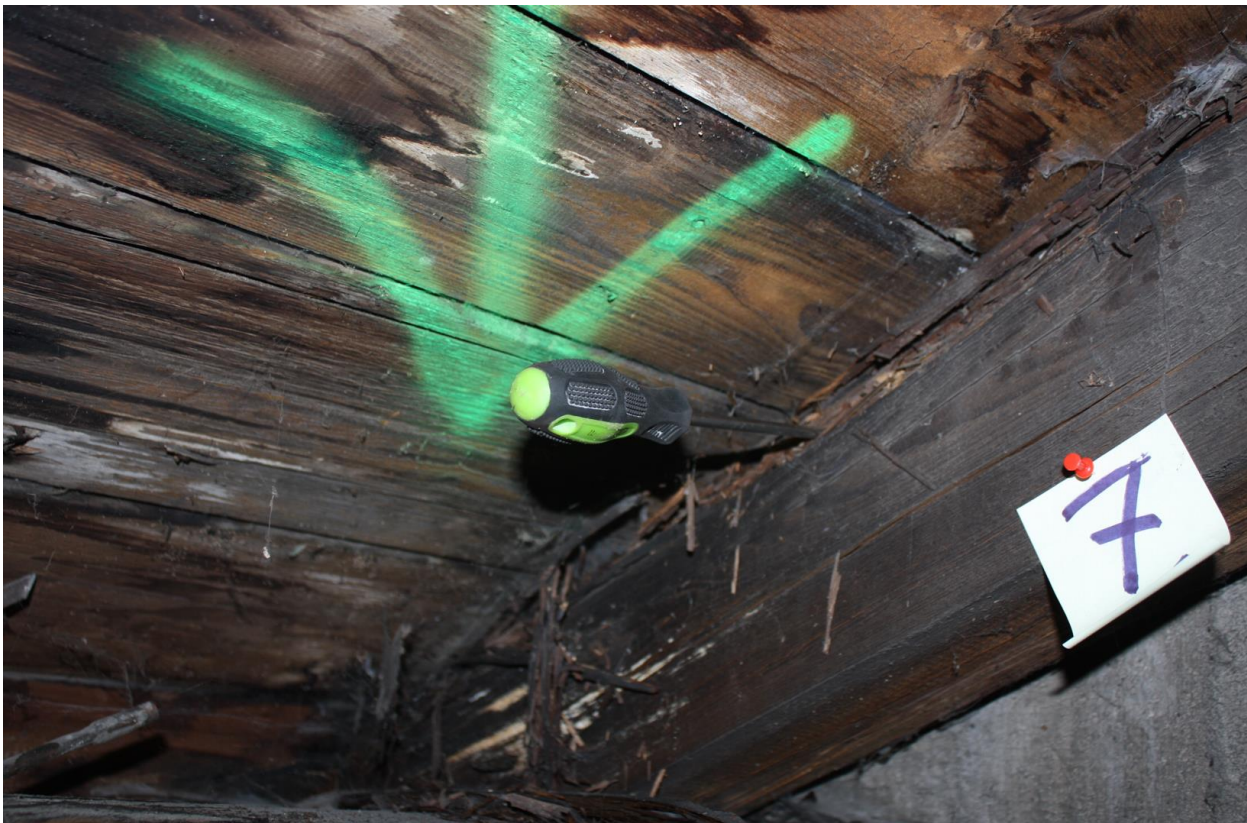
Fot. 7. Brunatny rozkład drewna
