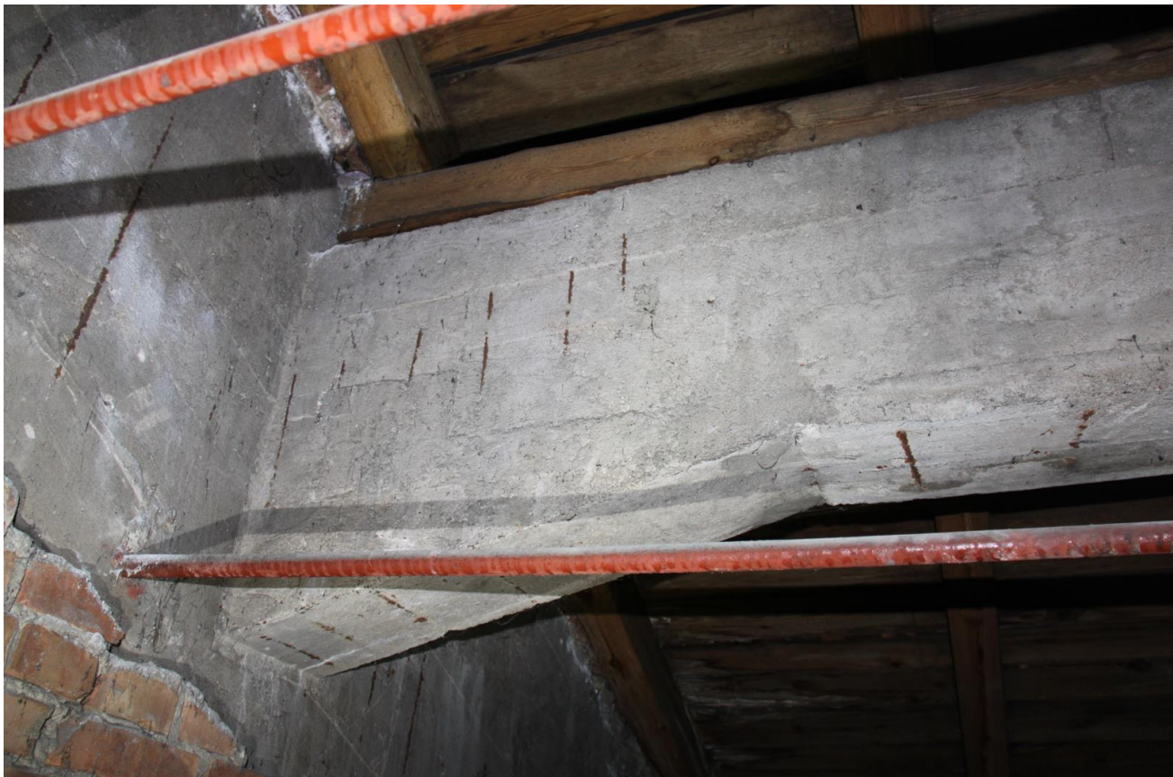
Fot. 11. Zbyt mała otulina prętów zbrojeniowych, przyczyniająca się do ich korodowania.
