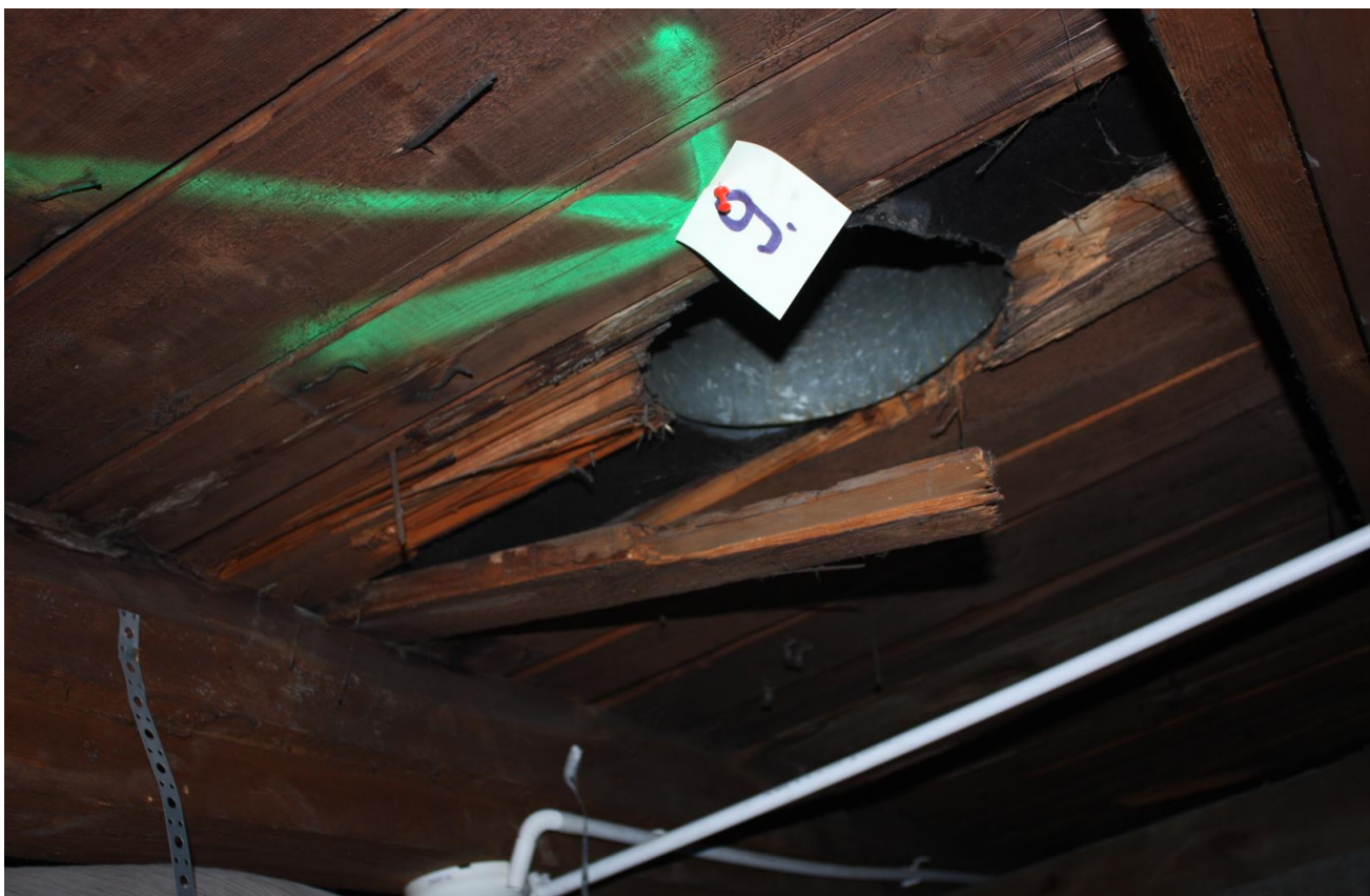
Fot. 9. Zniszczone, wyłamane deskowanie
