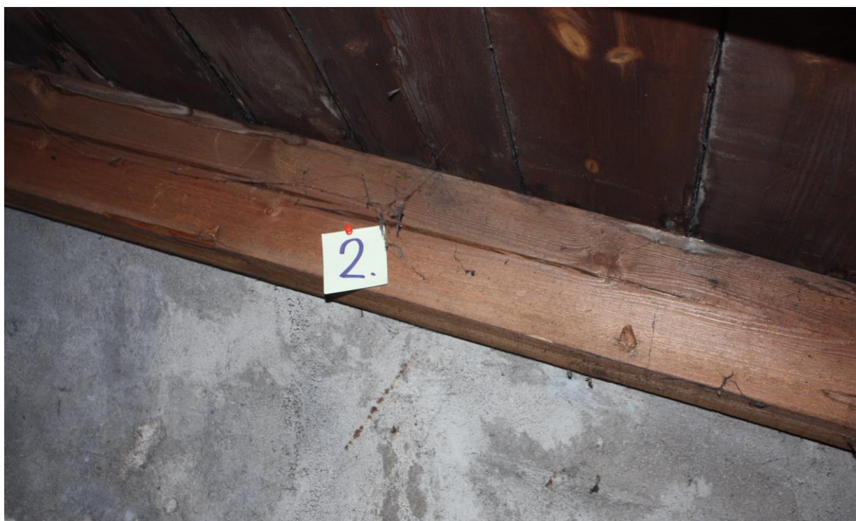
Fot. 2. Pęknięcie powierzchniowe
