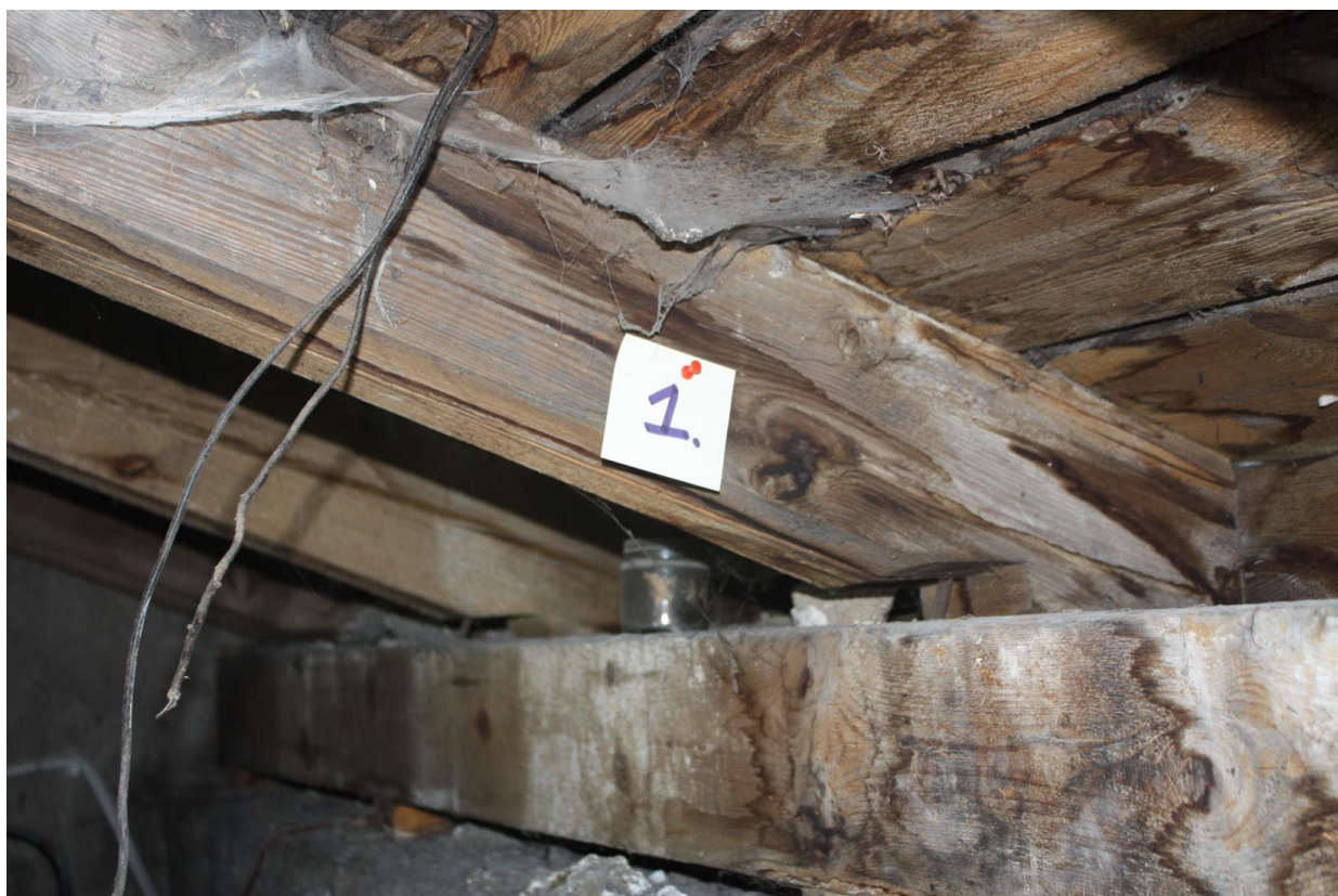
Fot. 1. Szczelina w węźle krokiew-murłata. Na zdjęciu widoczny jest także stan zachowania drewna.
