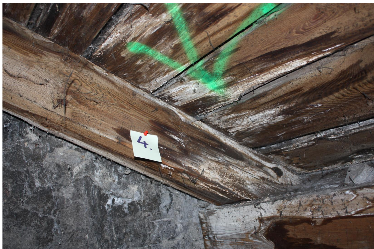
Fot. 4. Porażenie grzybem, wybarwienie drewna. Uszkodzenie pokrywa się z narożem pokrycia dachowego, w którym nie wykonano kozubka, zmieniającego kierunek odprowadzenia wód opadowych- naroże ścian.
